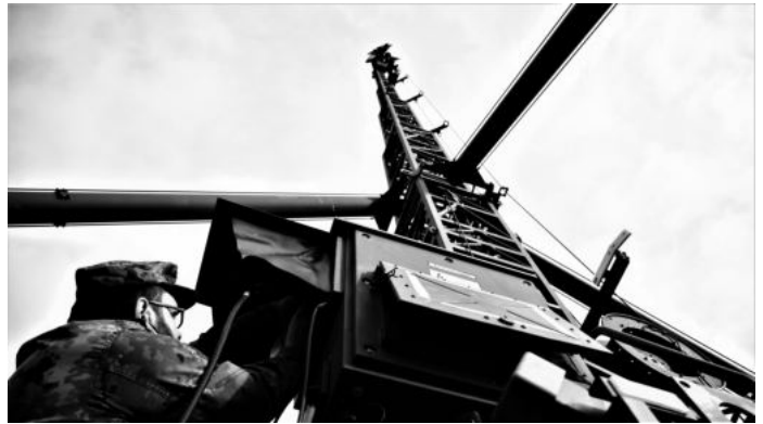
Bild oben: Der Antennenträger des Terrestri- schen Übertragungssystems (TÜtrSys) wird angebunden.
