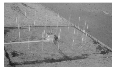
Bild 5 (oben) - HF-Peilstelle PST 396 in Peilhütte mit 6-fach Adcock
