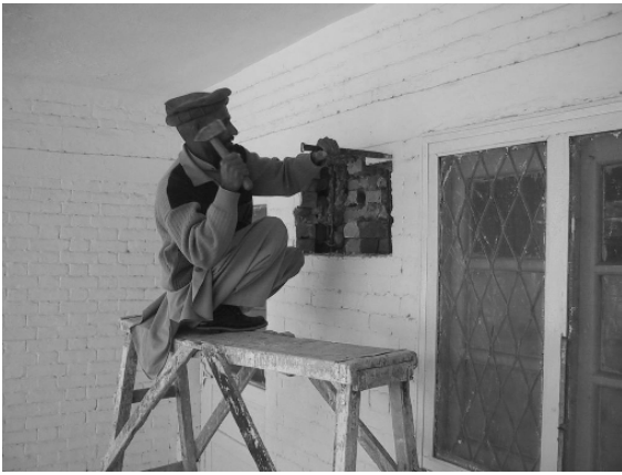
Teamwork: Vorbereitung (l.) und Vollendung (r.) des Einbaus einer Klimaanlage
