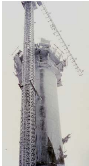
Bild 6 - Stahlbetonarbeiten am Turm der GFAST HOHER MEIßNER (1973): das Turmfundament von rund 750m 3 wird betoniert; der Turmschaft klettert in jeweils zwei Tagen um 3 Meter. Foto Heckrodt
