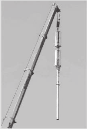
Einschweben“ der Mobilfunkantenne mittels Autokran im. März 2015
