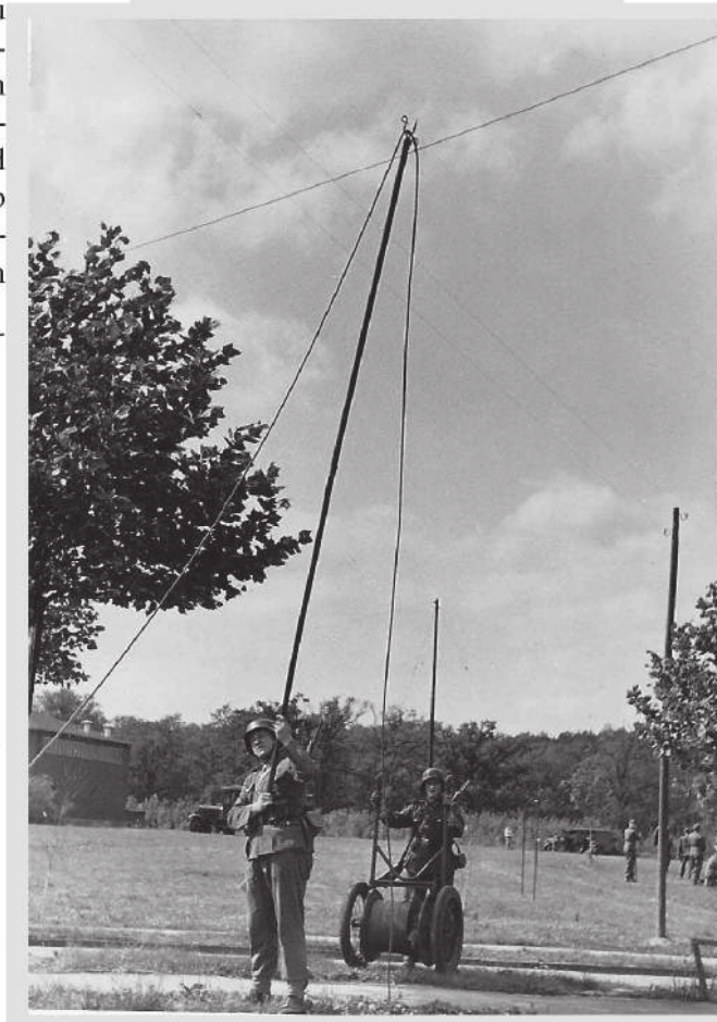
Bild 4: Bau von Feldfernkabel (Originalfoto aus [12])
