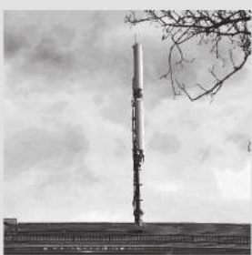
Fertig montierte Antenne auf dem Dach des Stabsgebäudes der FSBwIT
