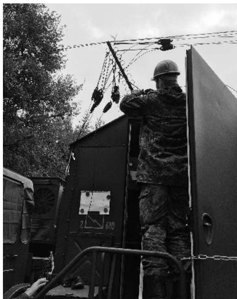
Verkabelung der Remuskabinen durch den Kabelbautrupp
