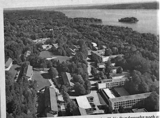
Die drei Sturmblockhäuser am linken Bildrand will die Bundeswehr noch aufre hinaus als Unterkünfte für Soldaten nutzen. FOTO: GEMEINDE
