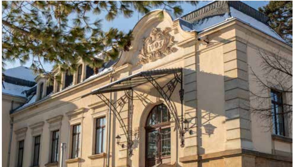
Abb. 1: Das Casino der OSH in Dresden. Foto: Bundeswehr/OSH-Pressestelle
