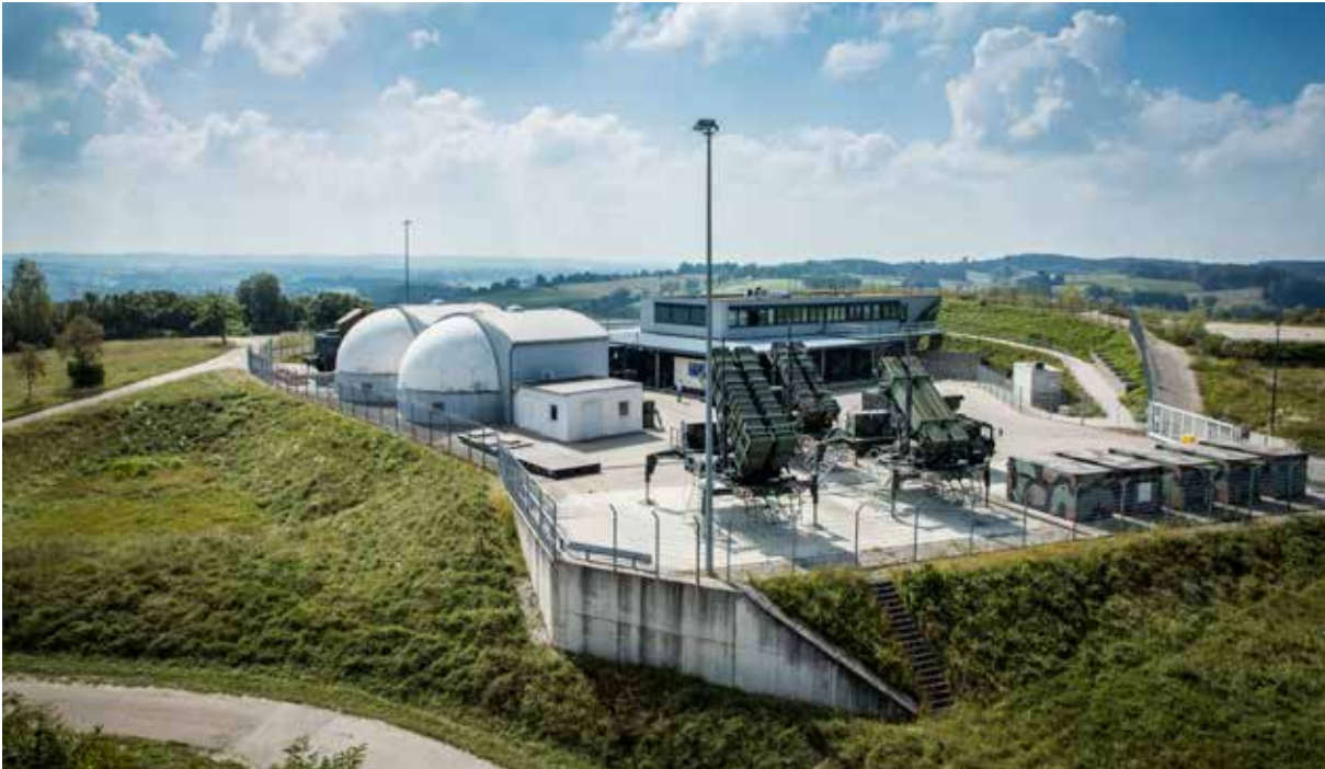
Abb. 1: Die Test- und Referenzanlage (TuRA) bei Schrobenhausen, zwischen München und Ingolstadt, bietet effiziente Möglichkeiten für praktische und theoretische Ausbildung, Foto: MBDA
