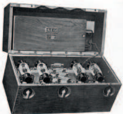
AEG - Überströmen-Verstärker KF 4 mit 3-Röhren Best. für Handverstellungsmöglichkeit
