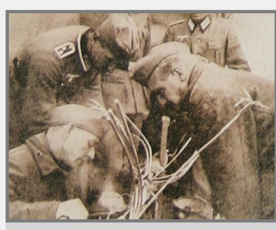
Im Auftrag der Wehrmachtführung hatte die DRP im Herbst 1941 begonnen, die Stabilität und Durchlassfähigkeit des von der Führungs-Nachrichtentruppen errichteten oberirdischen Liniennetzes durch die Auslegung unbespulter Fernkabel in mehreren Hauptrichtungen zu erhöhen. In der Regel folgten die unterirdisch verlegten und
