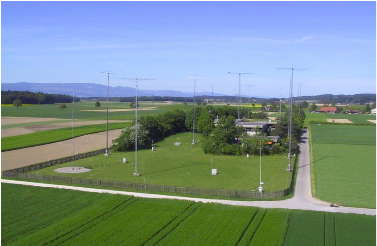
Die EPD/EDA Mittelland - Betriebs- und Empfangsanlage - befindet sich in Murain bei Ersigen BE , sie ist eine klassifizierte militärische Anlage.
