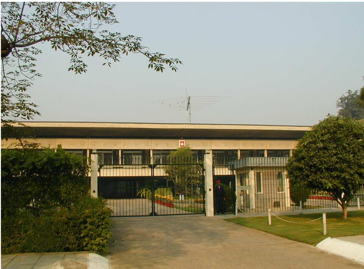
Die Schweizer Botschaft in New Delhi. Auf dem Flachdach ist eine LogPer Antenne LP-1007 zu sehen, später wurde diese entfernt. Es gab auch eine Breitbandantenne für den Scanner.
