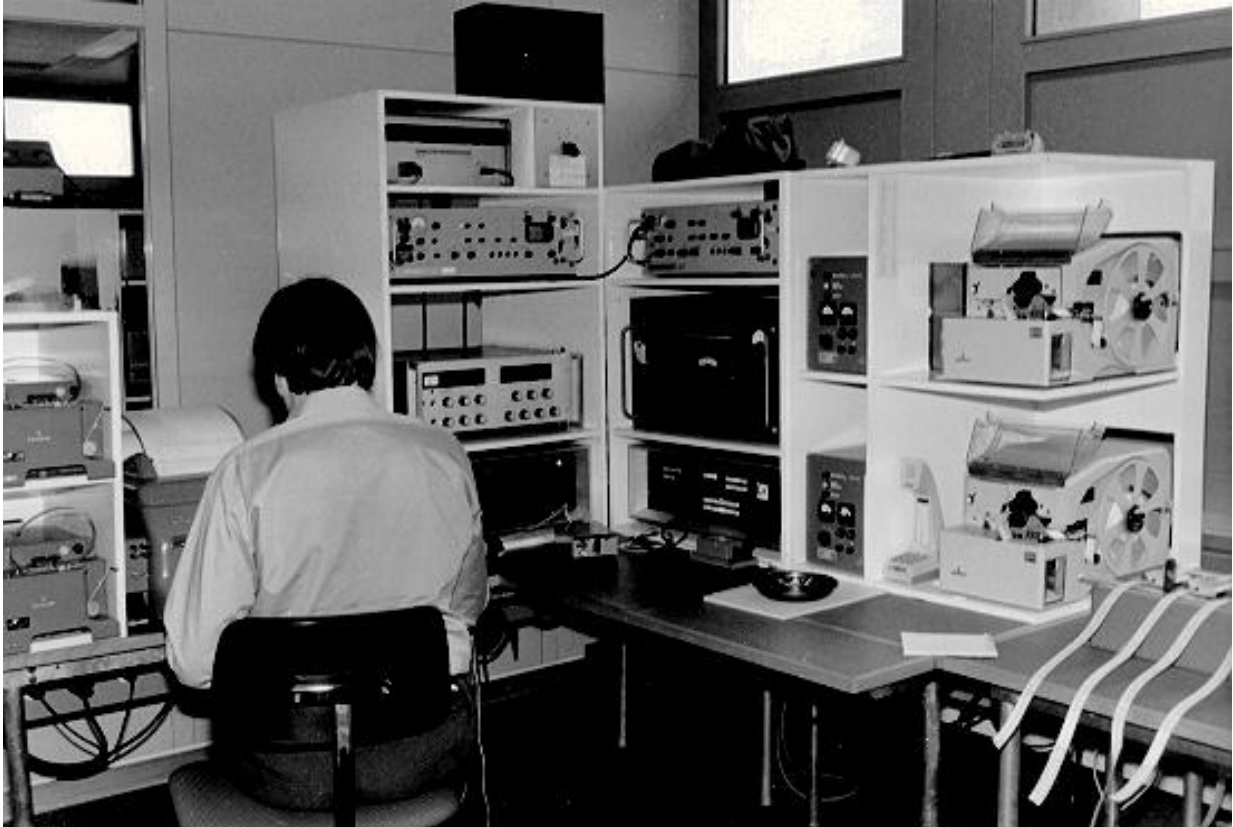
Eine F6 Funkfernsehreibanlage in der Mittellandzentrale Murain
