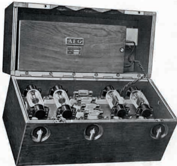
AEG - Vierröhren-Verstärker KF4 Mit X3-Röhren Auch für Funkentelegraphie anwendbar
