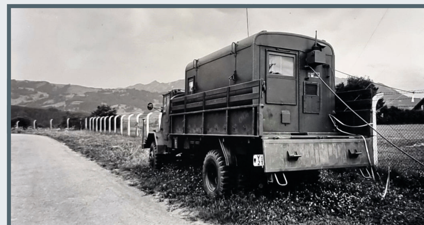
Einer der ersten Funkschreibtrupps - FuSchrGerSatz GRC 26 - Funkschreibeinrichtung (400-Watt-Sender) für mittlere und weite Entfernungen auf LKW mit Kabine
